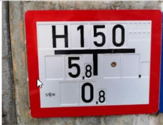
Hinweisschild zum Auffinden eines Hydranten
